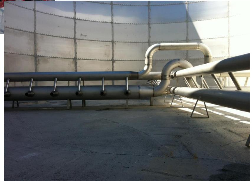
Reactor biológico 1600 m<sup>3</sup> y detalle del sistema de aireación.
